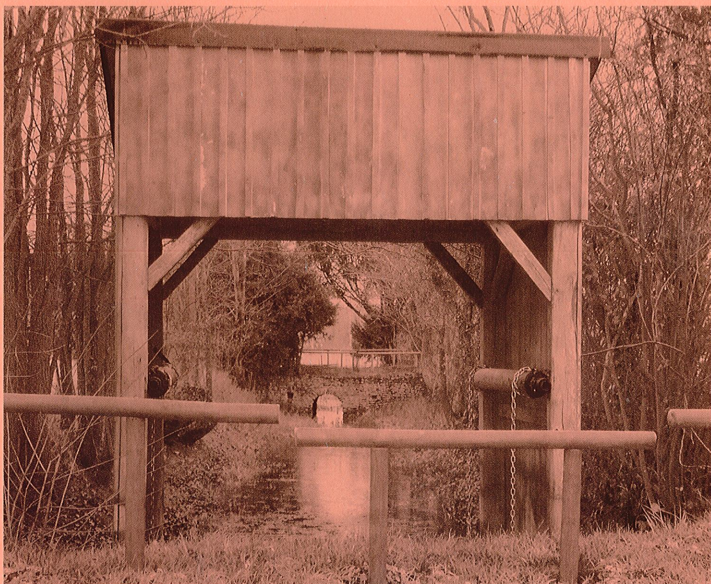
Lavoir à plancher mobile (Le bourg)
